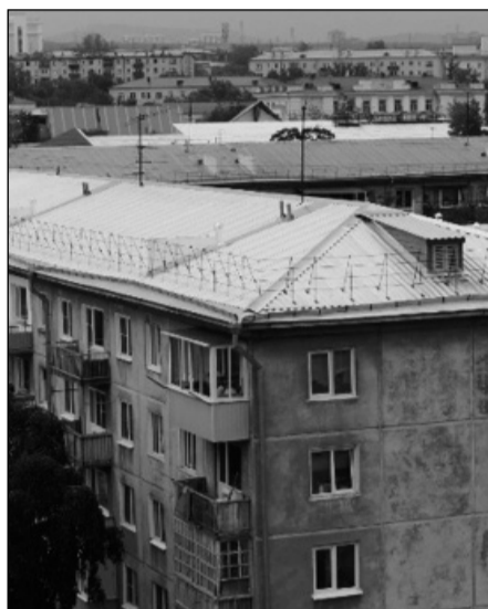
Ремонт кровли дома на ул. Солнечная, 29, до и после. Фото предоставлено Фондом капитального ремонта
